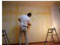
①壁の下地をパテで整え オンリーワン壁紙に 糊づけします
